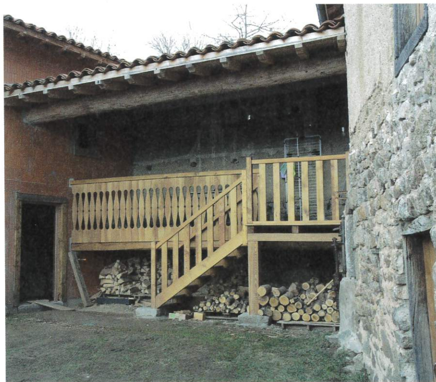
Garde-corps traditionnel de la galerie forézienne.
