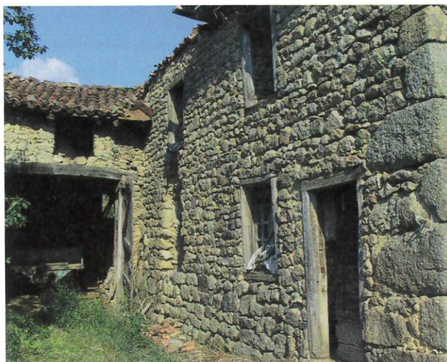
Façade sud en pierre et entrée de la grange en fond avant restauration.
