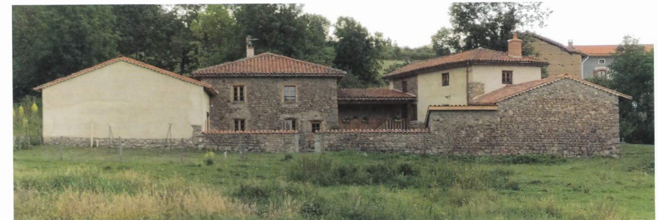
Vue d'ensemble façades sud, après restauration.
