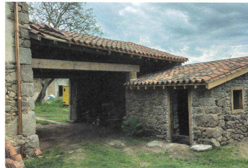
Descente de chéneaux en cuivre. Remplacement des cadres en bois des ouvertures du cabanon et du pilier en béton par un pilier en chêne.
