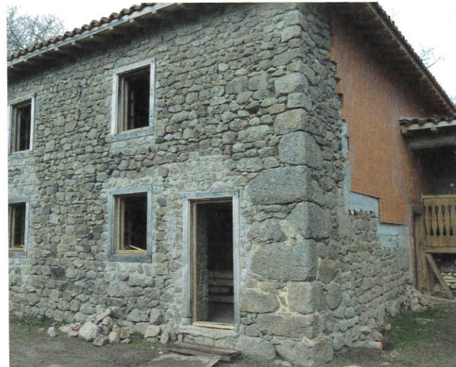
Pose de la toiture traditionnelle à 4 pans, de cadres d'ouvertures en chêne et reprise des murs en brique alvéolaire.
